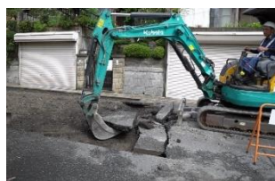
舗装のやり替え工事
